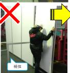
補強の出ている 方向から 補強の無い方向へ パネル設置作業
